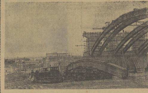
В Красноярске строится коммунальный мост через Енисей. Это будет уникальный по конструкции мост из сборного железобетона. Общая длина мостового перехода составит 2.100 метров.
