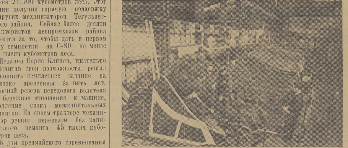
На снимке: сборка корпуса нового крылатого теплохода на заводе «Красное Сормово». (Фотохроника ТАСС).
