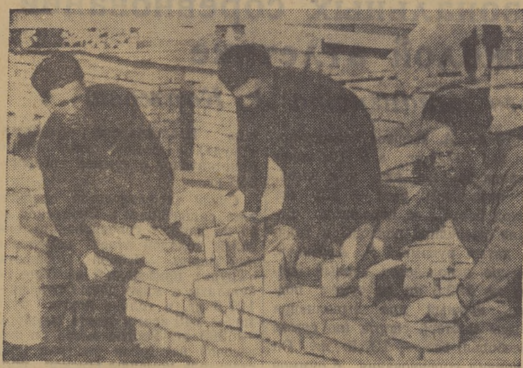
Среди строителей Томска широко известна трудовыми успехами бригада строителей тов. Пятова из треста «Томскстрой». Члены этого коллектива добились высокой производительности труда, выполняя до двух норм в смену. На снимке (слева направо): бригадир тов. Пятов, строители тт. Васильенко и Велья.
