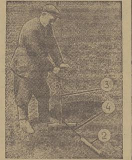
Снимок № 2. Натяжение мерной проволоки с помощью среднего штыря (3) натяжного кола и проверка натяжения динамометром (2). 4 — трос.
