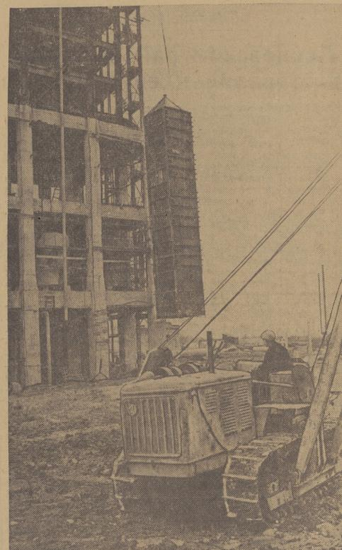
ЧЕЧЕНО-ИНГУШСКАЯ АССР. На строительстве установки непрерывного ковки талкалжия бригады Василия Гашина Грозненского строительного-монтажного управления с помощью шести тракторов С-80 подняли холодильный теплоноситель весом в 60 тонн на высоту 53,8 метра. Он является самым тяжелым аппаратом из технологического оборудования, монтируемого на эстакаде установки. На снимке: подъем холодильника теплоносителя. (Фотохроника ТАСС).
