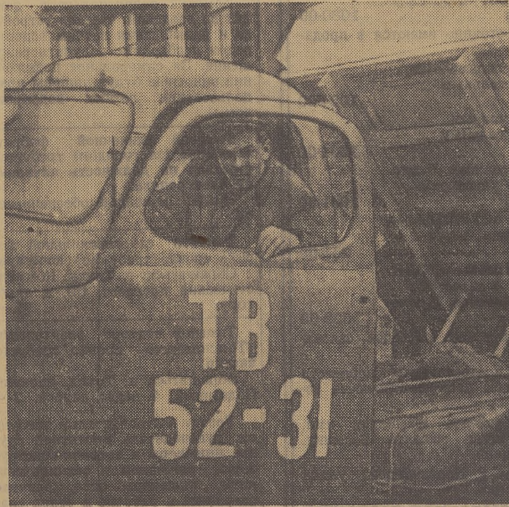
Шофер строительного-монтажного конторы «Сельэлектро» Н. А. Вонстинов сделал более тридцати рейсов на вывозе грунта для дорожного строительства.
