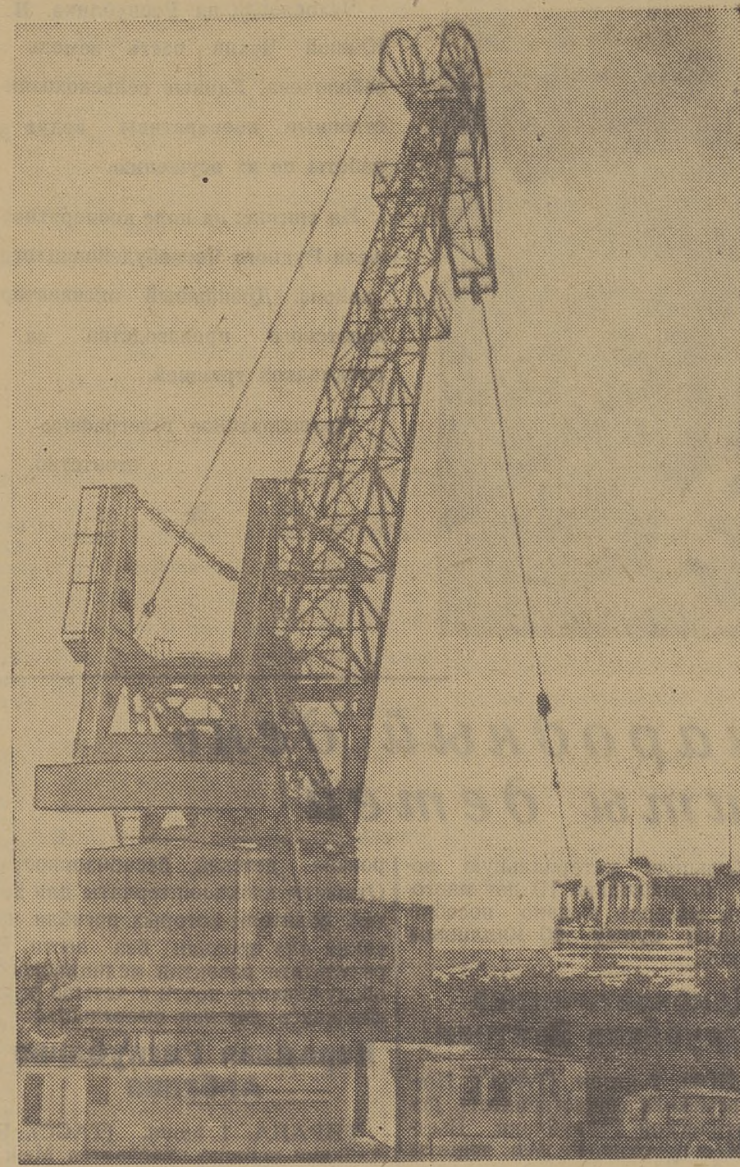
На Томском лесоперерабаточном комбинате в этом году механизирована разгрузка барж. На снимке: плавучий кран ПК-10 на рейде Томского лесоперерабаточного комбината.
