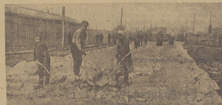
Рабочие Томского шпалопропиточного завода Михаил Иванович Гусельников, Никитин Иван Иванович Сильч и Мария Филипповна Меркулова на строительстве дороги по Нижне-Луговой улице г. Томска.
