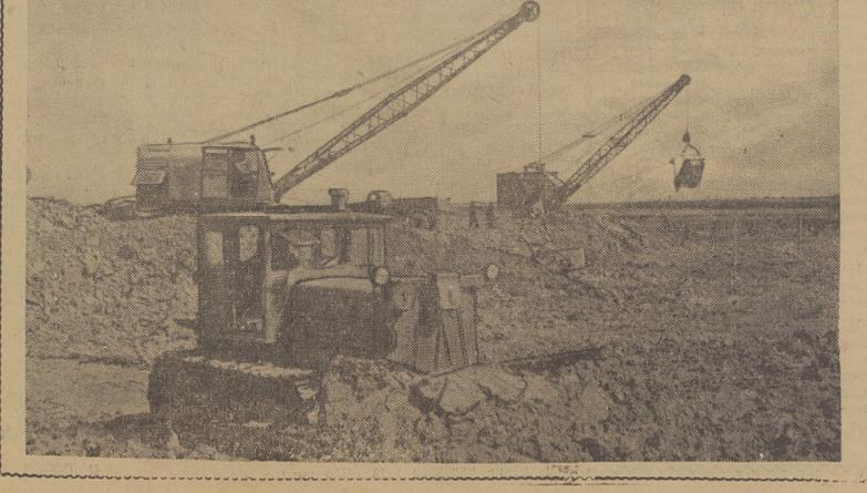
СТАЛИНСК. Началась подготовка к сооружению первого объекта будущего Западно-Сибирского металлургического завода — теплоэлектростанции. Механизаторы треста «Востокгидрострой» ведут выемку грунта под фундамент главного корпуса ТЭЦ. На снимке: рытье котлована под фундамент главного корпуса ТЭЦ. (Фотохроника ТАСС).
