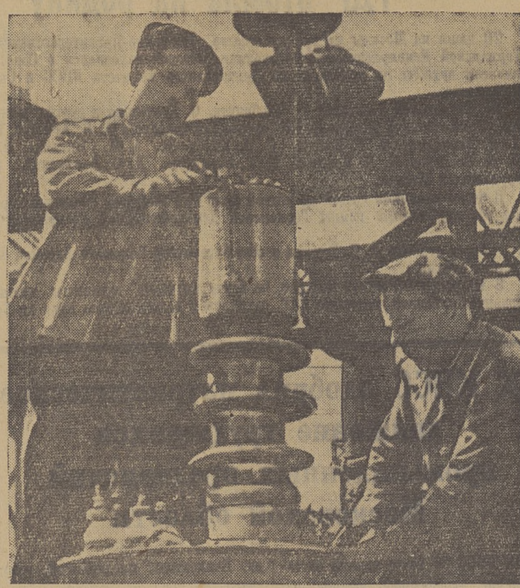
Хорошо трудятся в дни подготовки к июньскому пленуму ЦК КПСС монтажники электроцеха ГЭС-1. Они ведут монтаж высоковольтного масляного выключателя и установку измерительных трансформаторов.
