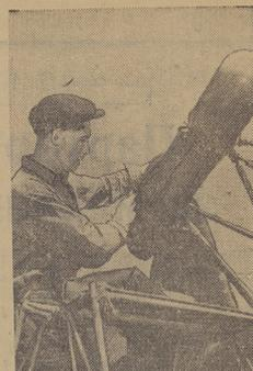
В районе Курской магнитной аномалии выявляются новые рудные месторождения. Геофизическая экспедиция ведет разведку с самолета при помощи аэроматричной аппаратуры. На снимке: магнитолог М. В. Дюда подготавливает магниточувствительный элемент гондолы к очередному полету. (Фотохроника ТАСС).
