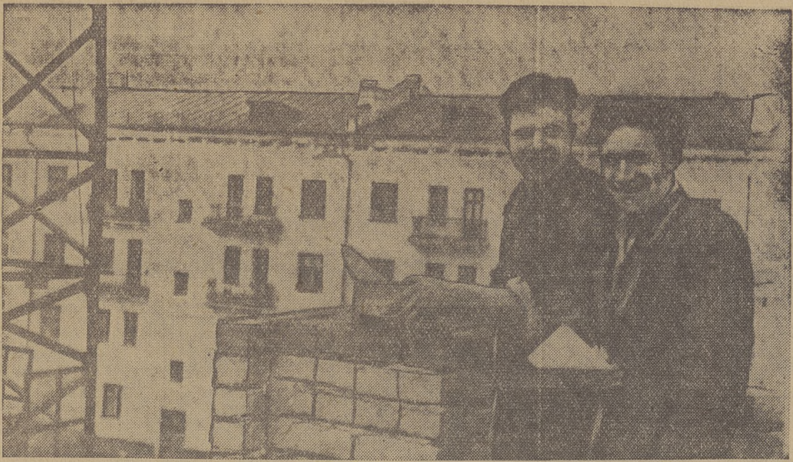
Коллектив второго строительного участка УНР 768 строит восьмидесятиквартирный дом для завода «Томнаш». Сейчас строители поднялись на леса четвертого этажа. Хорошо трудится бригада каменщиков-монтажников тов. Рекундаля. Сменное задание она выполняет на 150 — 160 процентов. На снимке: каменщик И. А. Волков и бригадир Н. А. Рекундаль (справа).
