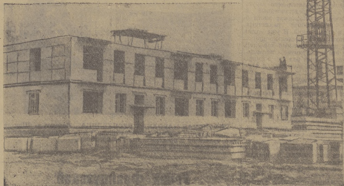
На снимке: монтаж 32-квартирного дома из крупных золоблоков.
