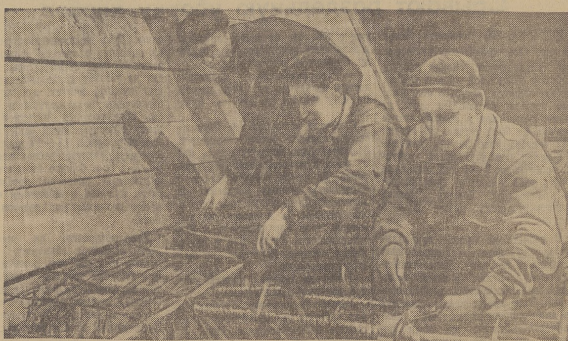
В УНР-290 треста № 97 высокопроизводительно трудится комплексная бригада строителей, которой руководит тов. Лопатин. Эта бригада ежедневно выполняет до двух норм. На снимке: (в центре) бригадир И. Д. Лопатин, члены бригады Э. Ф. Битнер и А. Я. Кедлер ведут арматурные работы. Фото Ф. Хитриневича.
