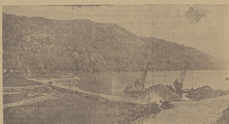
Строители крупнейшей в мире гидроэлектростанции на Енисее закончили отсыпку банкета поперечной перемычки левобережного котлована. Гряда из камня и гравия доведена до середины реки. На снимке: момент создания каменного банкета верховой перемычки левобережного котлована. (Фотохроника ТАСС).
