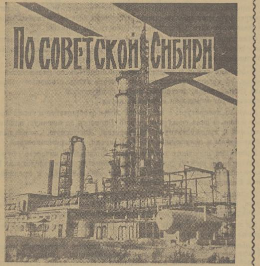
Омский нефтеперерабатывающий завод — одно из крупных предприятий в Сибири. Завод из года в год увеличивает переработку нефти. Предприятие расширяется, полным ходом идет сооружение второй установки каталитического крекинга. На снимке: действующая установка каталитического крекинга. (Фотохроника ТАСС).
