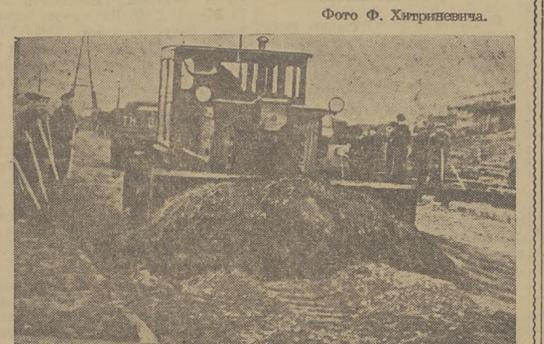
На снимке: бульдозер выравнивает полотно дороги на улице Ущельной.
