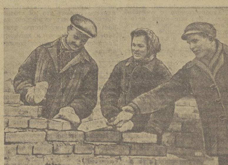
Первое трудовое «крещение» студенты-первокурсники Томского инженерно-строительного института из бригады Юрия Стадницкого получили на строительстве школы № 40. Закончив работы на этой стройке, они сейчас ведут кирпичную кладку стен 45-квартирного дома. На снимке: бригадир Юрий Стадницкий (справа), каменщики Галина Гилева и Виссарион Голубых. Фото Ф. Хитриневича.
