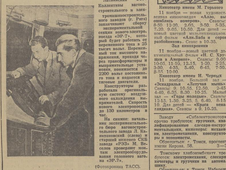
На снимке: начальники экспериментального бюро вагоностроительного завода Л. Капитановский (слева) и старший инженер СКБ завода «ЭР-7» М. Веселов проверяют монтаж электрооборудования головного вагона «ЭР-7».
