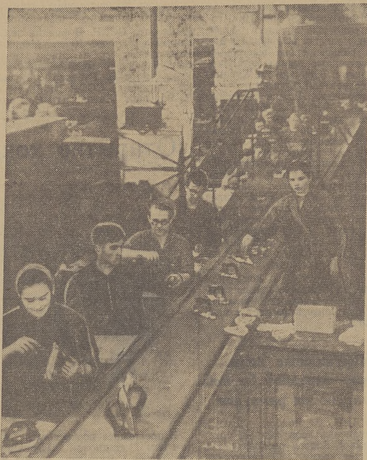
Вот он — новый конвейер по сборке электрических утюгов. Через весь цех протянулся он, связывая все сборочные операции в единый поток.
