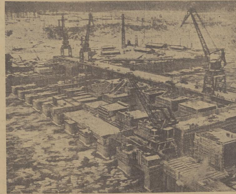
Иркутская область. Стремительная Ангара в районе строительства Братской ГЭС скоро будет скована крепким льдом. Несмотря на начавшиеся морозы, гидростроители успешно борются за то, чтобы обеспечить досрочный пуск первых агрегатов. Ежедневно перевыполняются графики укладки бетона в тело плотин. Успешно идет монтаж бетоновозных эстакад и другие работы. На снимке: общий вид строительства Братской ГЭС. (Фотохроника ТАСС).
