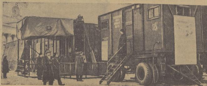
МОСКВА. На Выставку достижения народного хозяйства СССР поступил новый экспонат — передвижной мясокомбинат, изготовленный Алтайским вагоностроительным заводом. Смонтированный в шести автофургонах, он предназначен для первичной переработки скота в полевых условиях, в радиусе 100—150 километров от места приема. В смену в передвижном мясокомбинате можно обработать 750 голов мелкого скота и 30 голов крупного рогатого скота или 150 свиней и 30 голов крупного рогатого скота.
