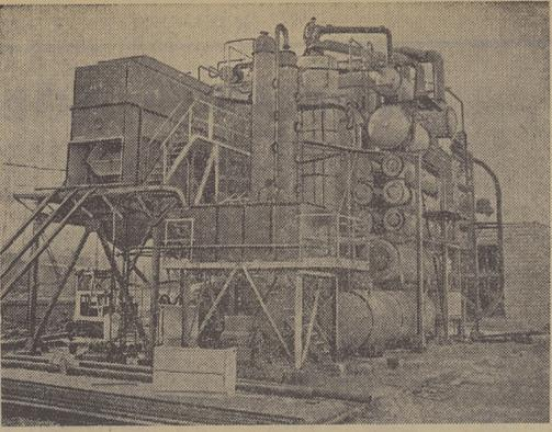
АЗЕРБАЙДЖАНСКАЯ ССР. На Кировабадском хлопкомаслоэкстракционном комбинате по проекту государственного проектного института «Гипрожир» сооружается первая в стране автоматизированная мазэкстракционная установка для повторной переработки жмыха. Все процессы производства здесь будут автоматизированы. Огромной установкой высотой в пятиэтажный дом будут управлять два техника. После ввода в строй нового цеха комбинат будет получать дополнительно около трех с половиной тысяч тонн масла в год.
