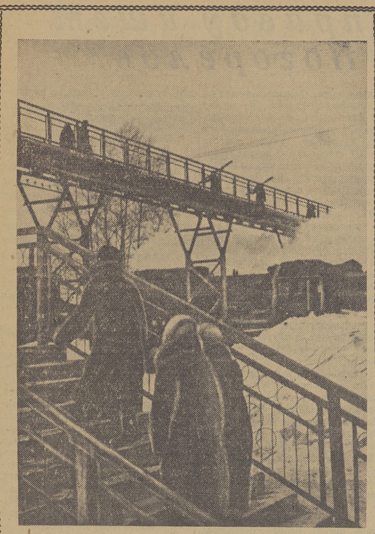
Недавно в районе станции Томск-I над стальными магистралями поднялся мост. Построен он по заказу избирателей поселка Степановка. Теперь обеспечен удобный переход через железнодорожные пути. На снимке: новый мост возле станции Томск-I. Фото М. Усачева.
