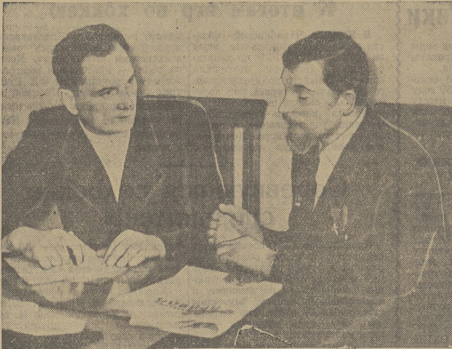
На снимке (слева направо): директор института новаторов-строителей, доцент Томского инженерно-строительного института А. И. Оболонин и член совета института Герой Социалистического Труда каменщик УНР-787 А. Т. Астратов обсуждают план работы секции производства и экономики строительных работ. Фото Ф. Хитриневича.
