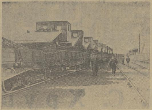
Предприятия комбината «Томлес» получают мощное техническое оснащение. На снимке: эшелон с трелевочными тракторами на станции Асино. Фото Н. Игнатовского.
