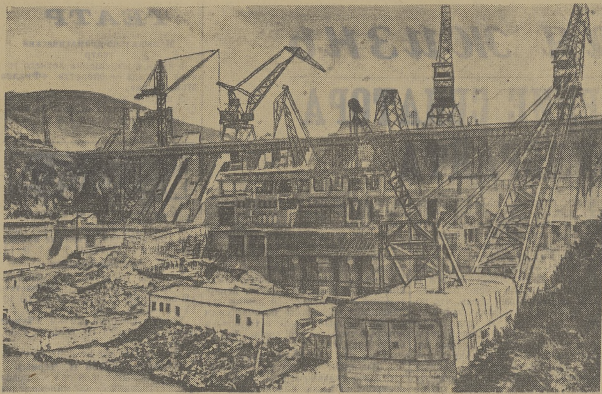
КАЗАХСКАЯ ССР. На строительстве Бухартинской гидроэлектростанции наступила предпоследняя пора. Строители и монтажники обзавелись в честь предстоящего Пленума ЦК КПСС досрочно, 14 августа, пустить первый агрегат. На снимке: вид Бухартинской ГЭС с нижнего берега. (Фотохроника ТАСС).
