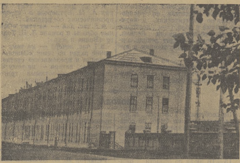
Недавно вступил в строй еще один новый корпус Томского машиностроительного завода. В его просторные залы перешли заготовительный, сборочный, малярный цехи.
