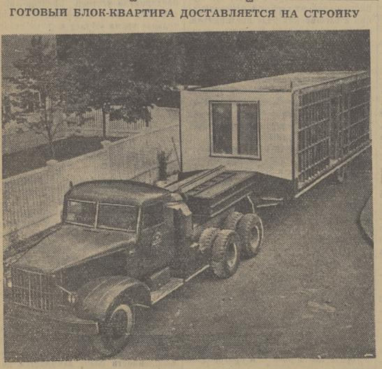
МОСКВА. На строительном заводе железобетонных изделий № 6 начато производство объемных элементов для строительства жилых домов, в том числе целых блок-квартир, из которых будут собираться жилые дома. Первое такое здание будет скоро собираться в 113-м квартале Новых Кузьминок. На снимке: блок-квартира на домовозе. (Фотохроника ТАСС)
