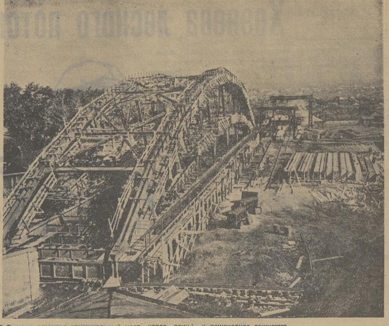
В Томске строится коммунальный мост через реку Туру. Средняя высота его от уровня воды составит 22 метра, а длина — 300 метров. По мосту предусмотрено двустороннее автомобильное и пешеходное движение. На снимке: арочный клепаный 104-метровый пролет моста. (Фотохроника ТАСС).
