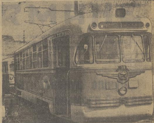
На Рижском вагоностроительном заводе изготовлен опытный образец нового трамвая «РБЗ-6». Он отличается бесшумным текорением колес и может развивать скорость до 65 километров в час. Ликвидация шумов достигнута путем изменения конструкции колес. Трамвайный вагон имеет 111 мягких мест, принудительную вентиляцию с подогревом воздуха в зимнее время. Вес нового трамвая по сравнению с выпускаемыми значительно снижен.
