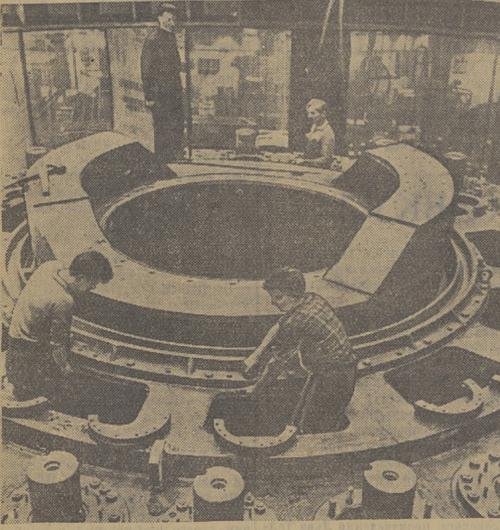
ЛЕНИНГРАД. В гидротурбинном цехе Металлического завода закончено изготовление головного образца турбины для Братской ГЭС. Мощность ее 236 тысяч киловатт. Управление машинной автоматизировано. На снимке: подготовка к испытаниям направляющего аппарата гидротурбины. (Фотохроника ТАСС).
