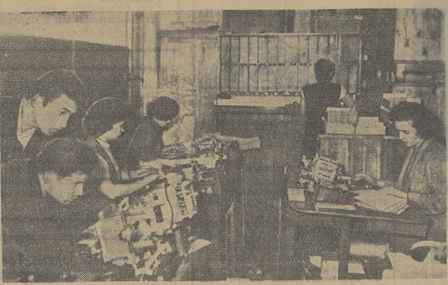
В этой небольшой комнате размещено большинство счетноаналитических машин.
