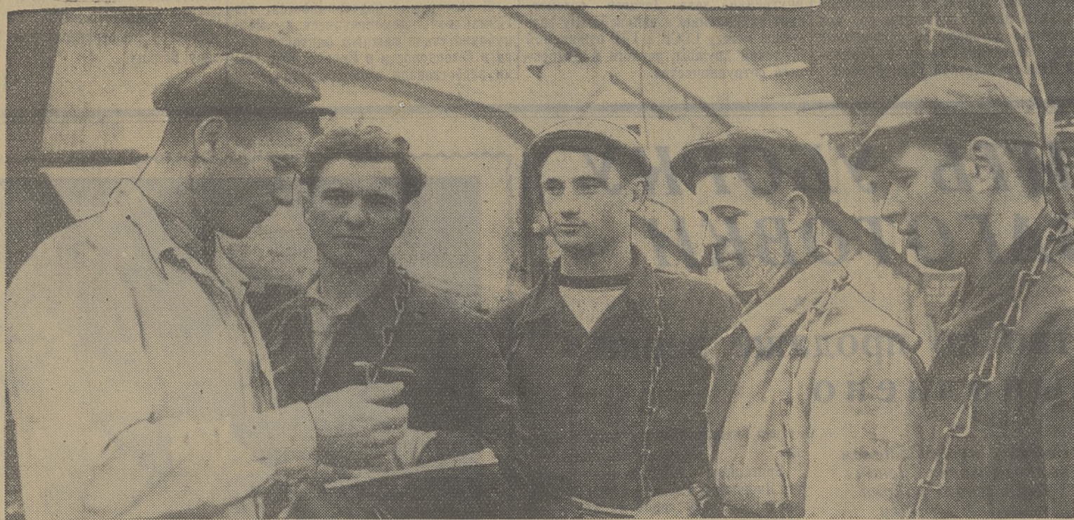
На трудовую вахту в честь 43-й годовщины Великого Октября становятся монтажники томского участка треста «Стальмонтаж». Они поддерживают почин строителей УНР-292 о своевременном вводе в строй объектов промбазы стройиндустрии.
