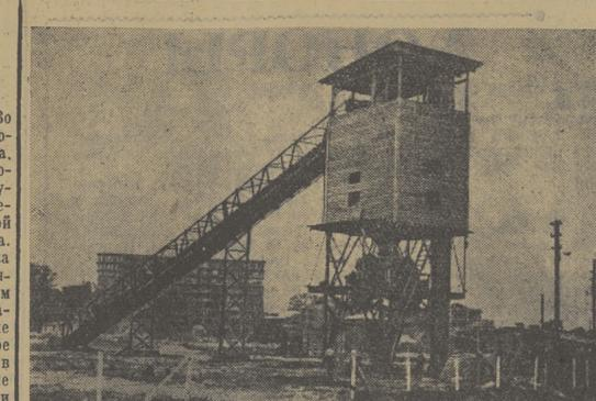
ТУРЦИЯ. В пригороде Стамбула с помощью Советского Союза построен бетонный завод производительностью около 50 тысяч кубометров бетона в год. Предприятие оснащено новейшей советской техникой. Все производственные процессы механизированы и автоматизированы.
