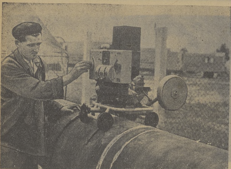
ПОЛЬСКАЯ НАРОДНАЯ РЕСПУБЛИКА. Быстрыми темпами сооружается гигантский нефтепровод, который свяжет СССР с Польшей, ГДР, Чехословакией и Венгрией. Транспортировка нефти таким способом кратит расходы по доставке на две трети. Строительство нефтепровода на территории Польши осуществляется в двух направлениях: из Плоцка к границе Советского Союза и из Плоцка в сторону ГДР. Работы на трассе в основном механизированы. На снимке: на строительстве нефтепровода в районе Плоцка. Сварка труб ведется с помощью советской сварочной машины. (Фотокорреспондент ТАСС).
