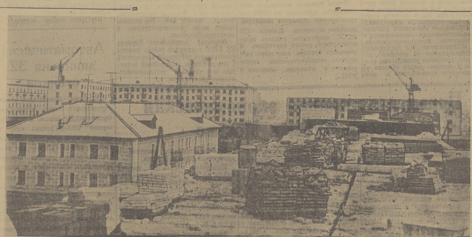
На снимке: строительство новых домов в районе станции Томск-1.
