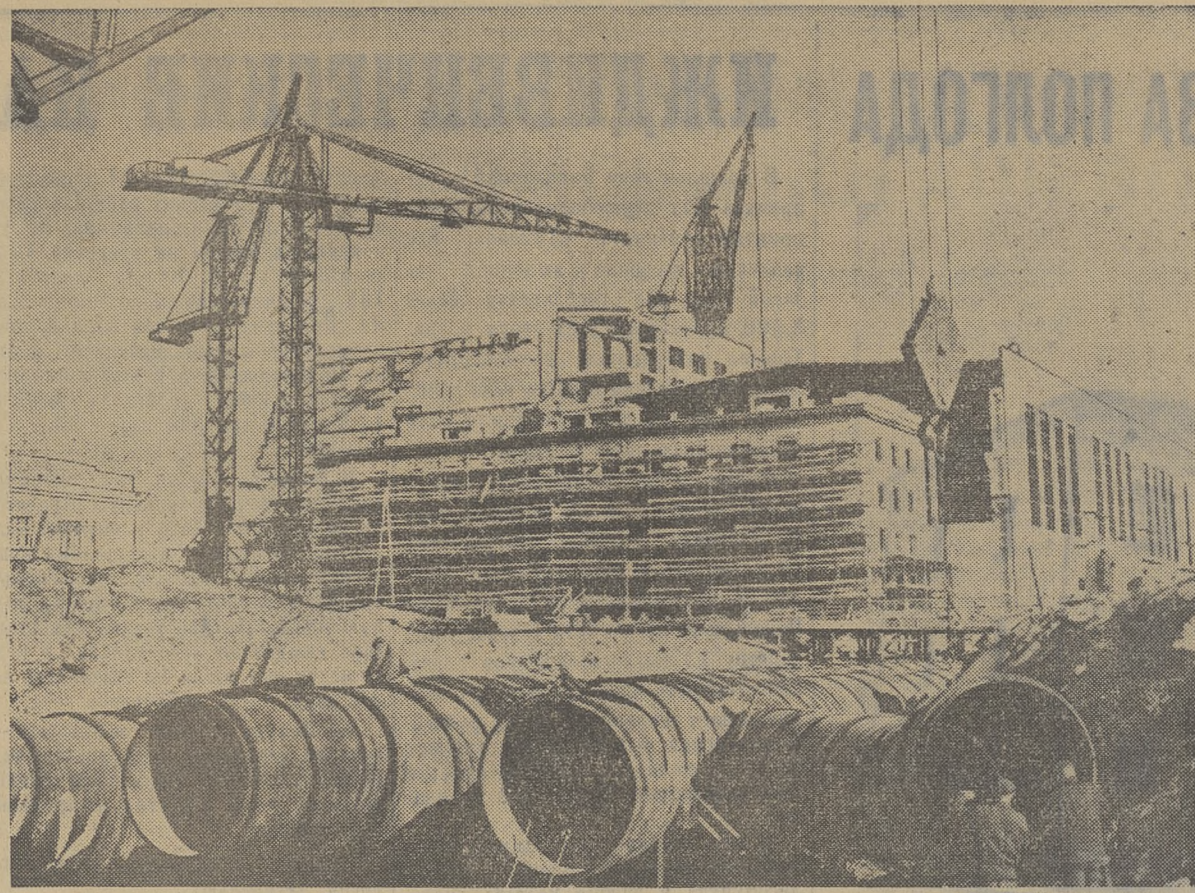
СВЕРДЛОВСКАЯ ОБЛАСТЬ. Строительство Белоярской атомной электростанции имени Курчатова. На снимке: монтаж водоподводящих и отводящих трубопроводов электростанции. (Фотохроника ТАСС).
