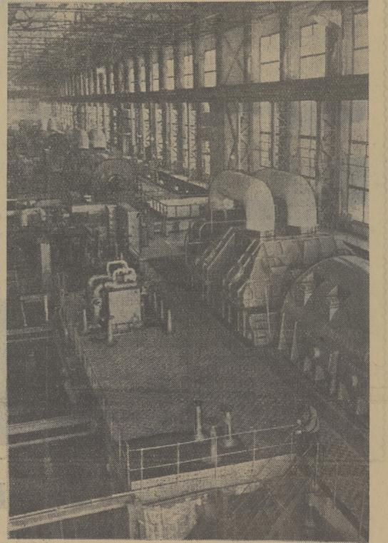
В Кузбассе строится мощная тепловая электростанция — Томско-Усинская ГРЭС. Монтажники заканчивают сборку пятого турбоагрегата. С вводом его в эксплуатацию будет завершено сооружение очереди электростанции. На этой же станции собран и уже действует автотрансформатор на 240 тысяч киловольт-ампер. На днях будет подключен второй такой автотрансформатор.
