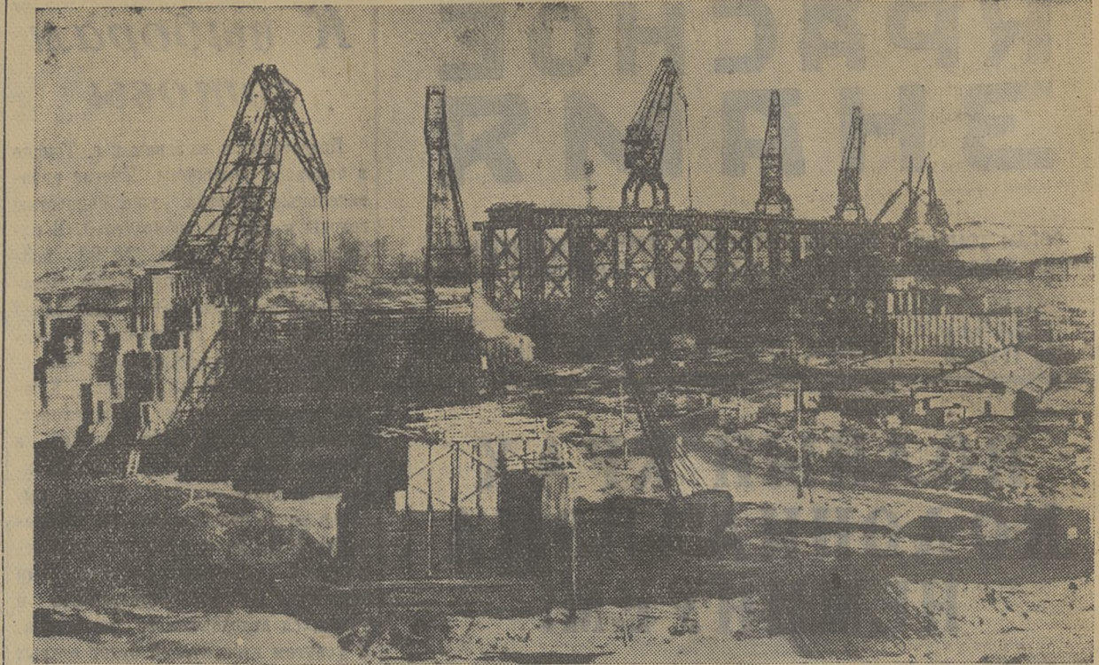
Строители Воткинской ГЭС на реке Каме борются за выполнение принятых социалистических обязательств — досрочно пустить первые два гидроагрегата в 1961 году. Готовя достоянию 40-летнюю Ленинского плана ГОЭЛРО, коллектив нарабатывает темпы ускорения в основном строительстве.
