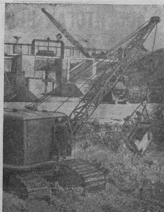
УЗБЕКСКАЯ ССР. На трассе Большого Ферганского канала началась реконструкция нижней части этой водной магистрали. На протяжении 90 километров канал будет углублен и расширен, что увеличит его пропускную способность. Это даст возможность дополнительно орошать более 20 тысяч гектаров земель, в том числе несколько тысяч га целинных земель Центральной Ферганы. На снимке: углубление канала у Первомайского гидросооружения. (Фотохроника ТАСС).
