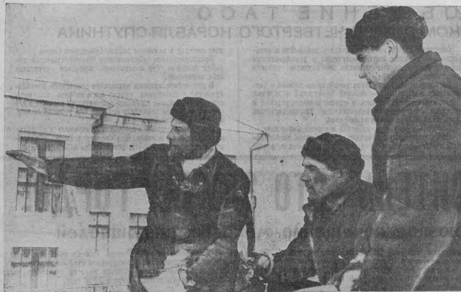
Успешно выполняет обязательства, принятые в честь XXII съезда КПСС, комплексная хозяйственная бригада Героя Социалистического Труда А. Т. Астратова на УНР-787. Этот дружный коллектив возводит здание общежития школы-интерната по Сибирской улице в Томске. Каждый строитель бригады ежемесячно выполняет нормы на 110—115 процентов. На снимке (слева направо): бригадир А. Т. Астратов и строители Н. А. Пучков и В. Е. Ушнурцев. Фото Ф. Хитриневича.
