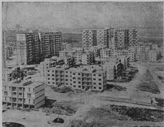
КУБА. Гавана. Строительство нового жилого района в пригороде столицы страны.
