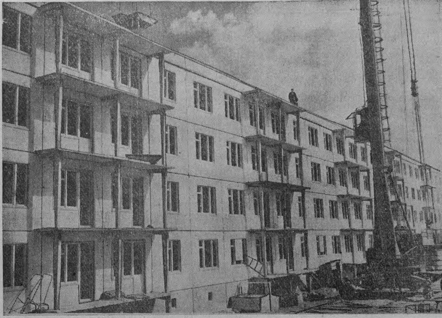
В первом микрорайоне подмосковного города-спутника в районе станции Крюково развернуто строительство жилых зданий. Закончен монтаж двух четырехэтажных домов из тонкостенных касетных панелей, возводятся девятиэтажные здания из крупных блоков, строятся детские учреждения, магазины. В этом году намечено сдать в эксплуатацию 15.000 квадратных метров жилой площади и школу, рассчитанную на 920 учащихся.
