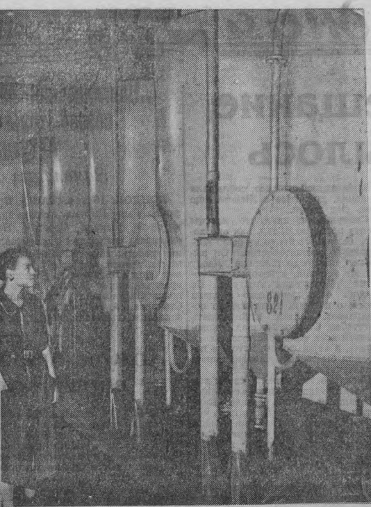
Конструкторы Томского завода резиновой обуви совместно с работниками энергомеханического отдела, электромеханического и котельного цехов реконструировали лапарочное отделение цеха вулканизации. В лапарочном отделении выстроены второй этаж, установка оборудования замесно новым.
