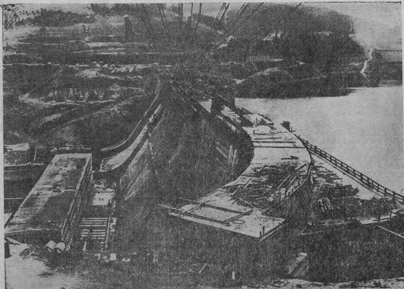
Чехословацкая социалистическая республика. На реке Влтава у Орлика сооружается крупнейшая в Европе гидроэлектростанция. Высота плотины, воздвигнутой из бетона, — 91 метр. Водоём протянулся в длину на 71 километр.
