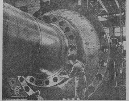
ЛЕНИНГРАД. Турбостроители Металлического завода работают над созданием первой гидравлической турбины для ударной стройки семилетки — Воткинской ГЭС. Эта поворотная-лопастная турбина будет мощностью сто тысяч киловатт. На снимке: токарь-расточник В. П. Петухов (слева) и подручный Н. Ф. Белок соединяют вал с крышкой цилиндра рабочего колеса турбины. (Фотохроника ТАСС).
