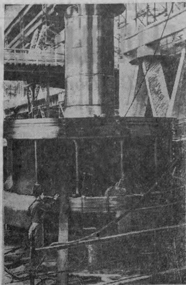
Иркутская область. В конце июня на основных сооружениях Братского гидроузла начата сборка рабочего колеса и других деталей первого агрегата. На снимке: сборка рабочего колеса. (Фотохроника ТАСС.)
