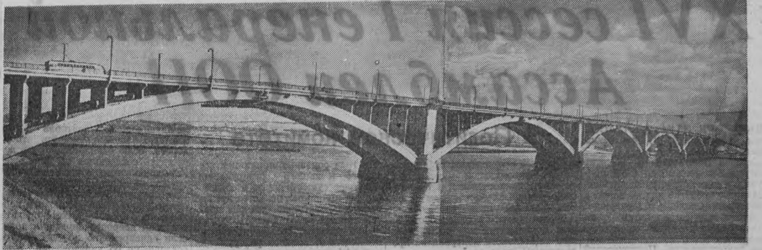
КРАСНОЯРСК. Завершено сооружение моста, который связал оба берега Енисея. Длина моста — два с половиной километра. По предложению инженера П. Егорова арочный мост выполнен из сборного железобетона. Установка сводов на постоянные опоры производилась с плавучих средств. Это позволило значительно снизить трудовые затраты и стоимость строительства, сократить сроки работы.
