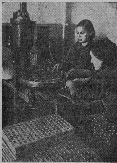
Рационализаторы Томского электролампового завода В. И. Корнев и П. И. Тимофеев сконструировали к полуавтомату насадки доковой приспособление для крепления латунных стаканчиков долей. Новое приспособление позволило механизировать процесс насадки стаканчиков, улучшить условия труда. Приспособление позволяет предприятию экономить ежегодно 2.200 рублей. На этом снимке запечатлен модернизированный автомат в действии. Работницы с благодарностью отзываются о творческой работе рационализаторов.
