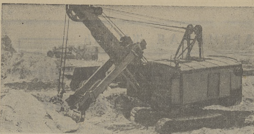
ПОЛТАВСКАЯ ОБЛАСТЬ. Близ Кременчуга сооружается крупный Днепровский горнообогатительный комбинат. Производственные работы на руднике Днепровского горнообогатительного комбината. (Фотохроника ТАСС).
