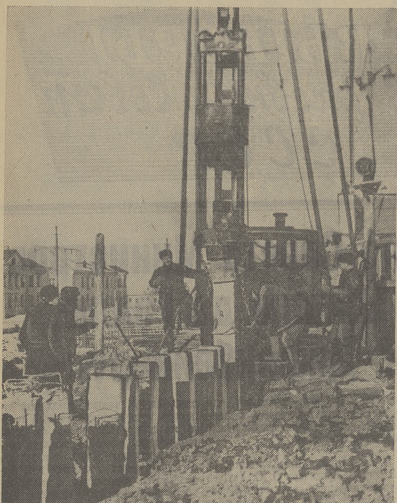
Впервые в практике томских строителей возводятся производственный корпус манометрового завода на железобетонных сваях. Весь процесс механизирован. Для этого используется трактор «С-80», оборудованный дизелькомом. Руководит работами прораб В. Гуцун и мастер Р. Кузнецов — выпускники Томского инженерно-строительного института. Сейчас на строительной площадке идет подготовка к бетонированию.
